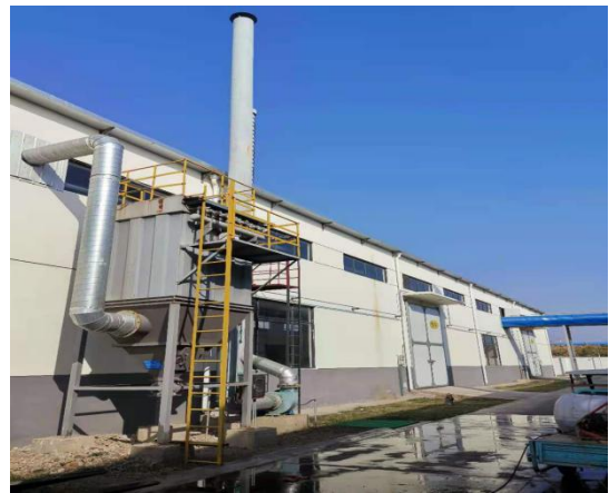
DA003 粉末车间包装车间排气筒及处理装置
