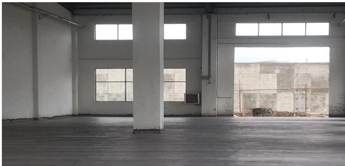
地面防腐防渗照片
