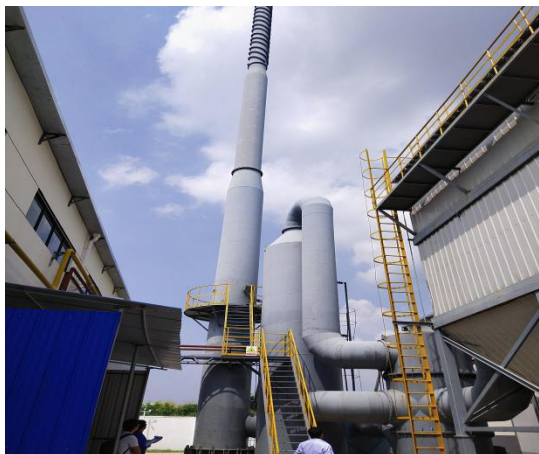
DA001 粉末预处理和原料仓库排气筒及处理装置
