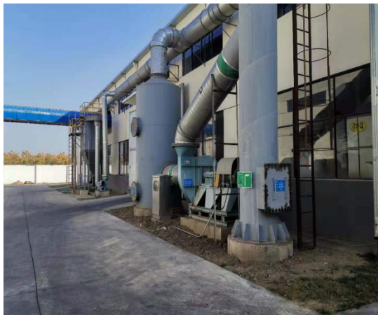
DA001 粉末预处理和原料仓库排气筒及处理装置
